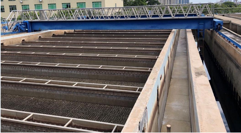
图 4.6-1 现状斜管沉淀池
