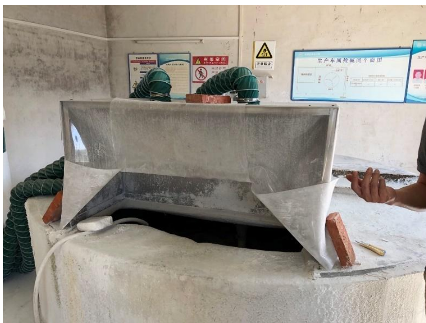
图 3.9-4 石灰投加系统
