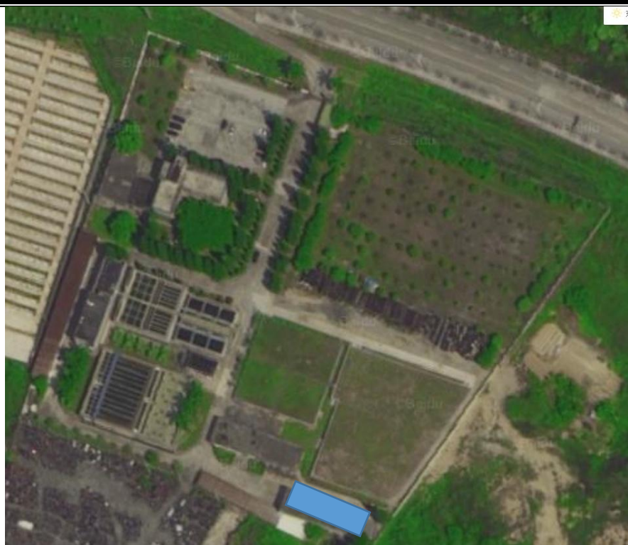
图 4.8-4 变电所位置（旧发电机房改造）
