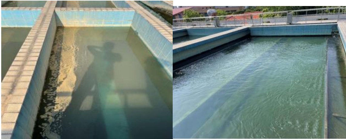
图 3.2-1 中堂水厂构筑物现状照片
