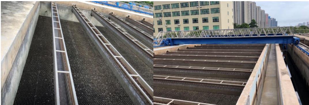
图 3.7-2 一期斜管沉淀池
