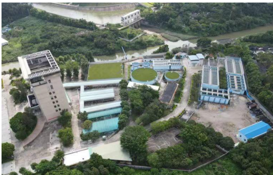
图 3.14-1 塘厦中心水厂现状照片
