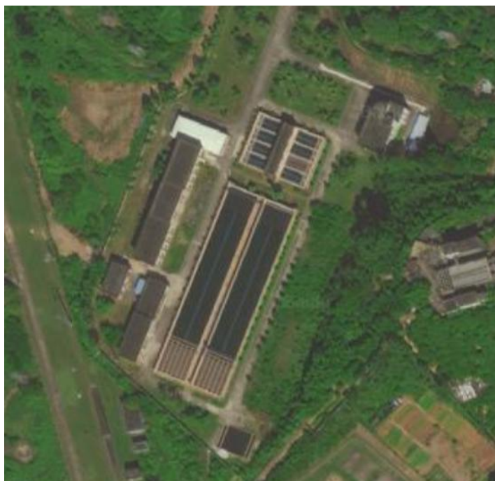
图 3.11-1 凤岗第二水厂卫星图
