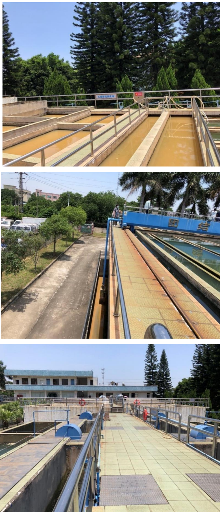
图 3.9-2 现场调研照片
