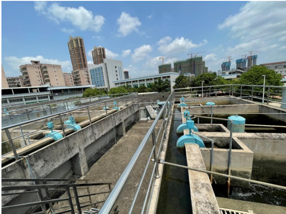
图 3.3-4 石碣水厂虹吸滤池
