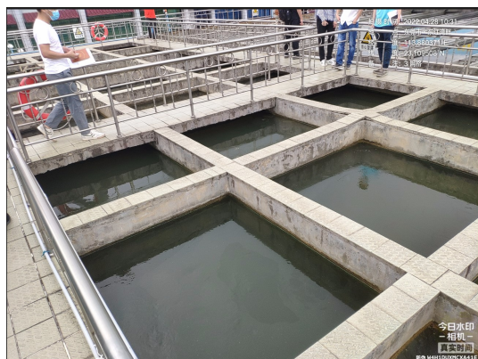
图 8-10 黄洲水厂网格絮凝池
